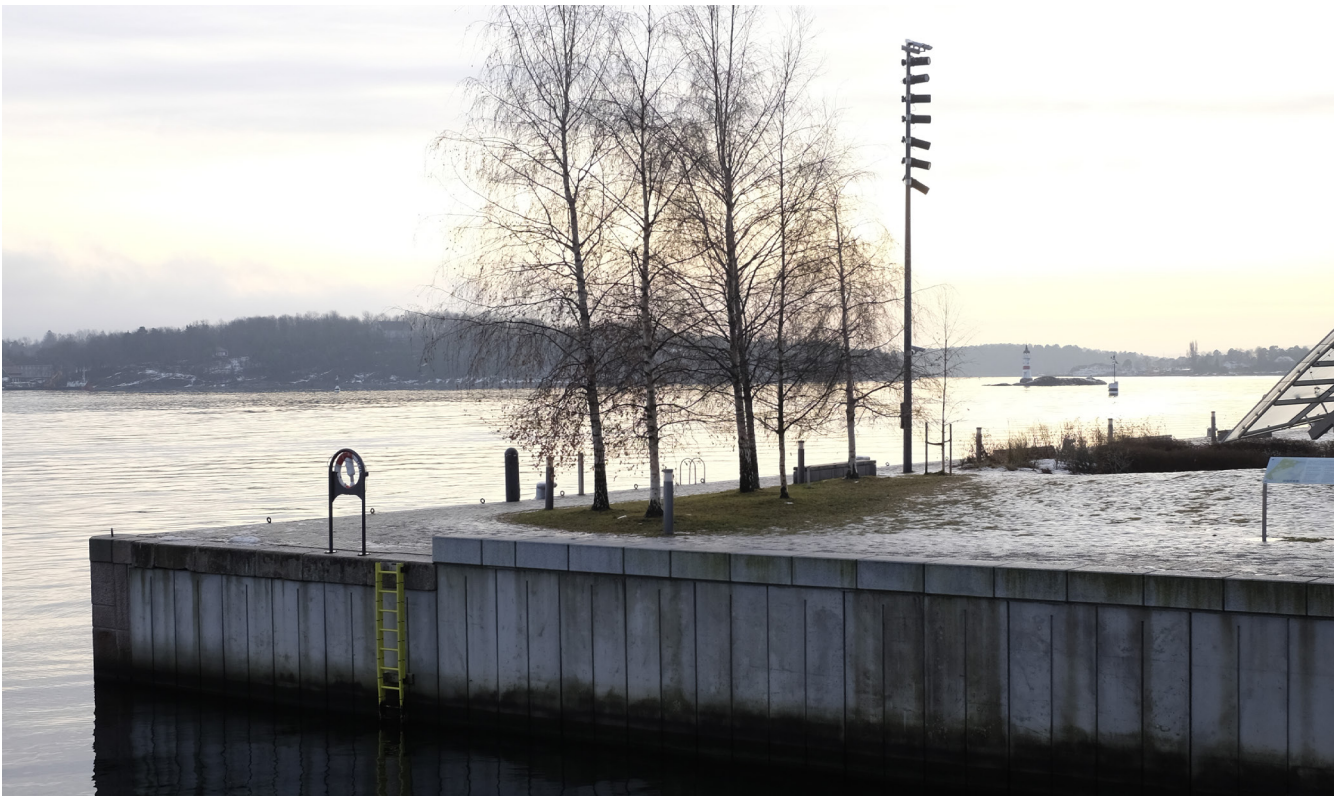
På Tjuvholmen har bryggekannten fall mot sjøen. Når det er isete og glatt kan man skli ut i vannet uten at det er noe å holde seg fast i eller sette foten på. Foto White arkitekter.
